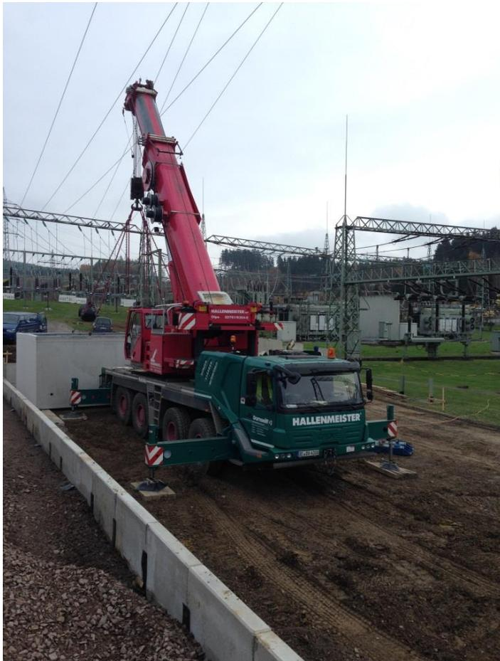
*Der HALLENMEISTER® setzt die erste Garage unterhalb der Trasse und unter besonderer Berücksichtigung des Schutzabstands zu den Hochspannungsleitungen. Der Winkel der Anschlagmittel war vorgegeben.*
