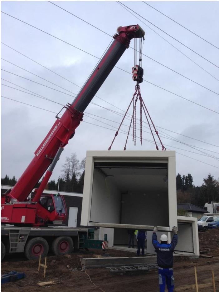
*Das Entladen der Fertigbauwerke musste ausladungsbedingt mit einer Auslegerlänge von 14 m durchgeführt werden.*
