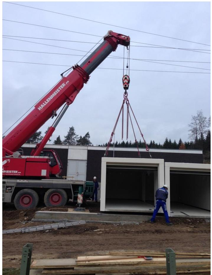
*Zum Positionieren der zweiten Garage vor dem Heck des HALLENMEISTER® wurde der Ausleger durch Einteleskopieren auf 10 m Länge reduziert.*
